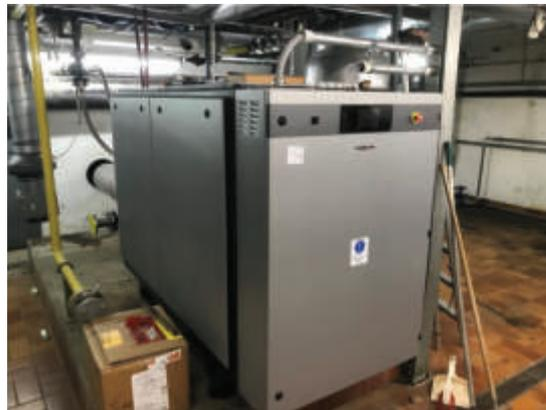
Abbildung 74: Neuer Heizkessel (links) und Blockheizkraftwerk (rechts)
