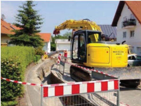
Abbildung 70: Verlegung KMR-Rohr
