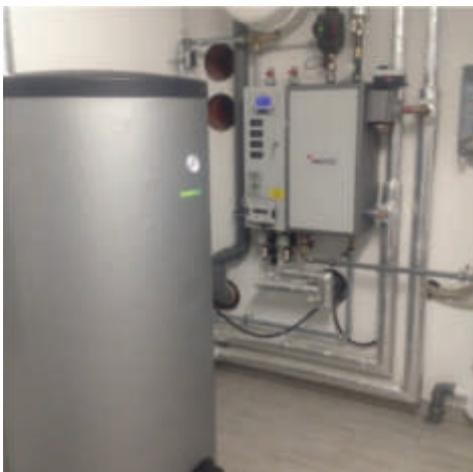
Abbildung 71: Übergabestation (Mitte) und Warmwasserspeicher (links)
