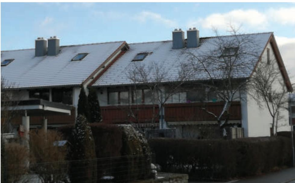
**Abb. 24:** Gebäude im Quartier mit separaten Heizungsügen für Beistellöfen
