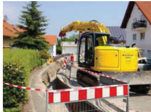
Abb. 45: Verlegung KMR-Rohr
