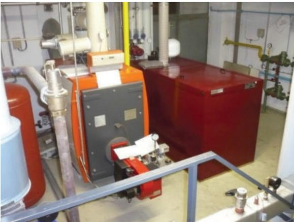
Abbildung 35: Heizkessel (links) und BHKW (rechts) Seelhaushalle
